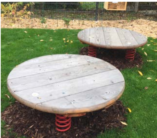
Das Springen von einer Hüpfplatte auf die andere wäre durch den Sicherheitsabstand, den die Platte bei Einzelaufstellung benötigt, nicht möglich.
