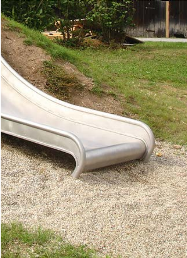
Beim Rutschen führt man eine schräge bis horizontale Bewegung aus, daher ist loser Fallschutz die erste Wahl. Durch Wegspielen des Fallschutzmaterials wird man „sanft“ gebremst.
