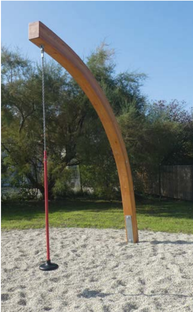
Die bei Einstammkonstruktionen/Einmastkonstruktionen geforderte Revisionsöffnung ist bei losem Fallschutz leicht zu bewerkstelligen.
