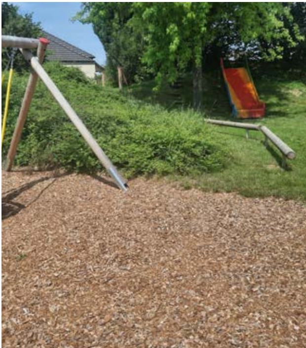
Dieser bodenbündige Übergang von Wiese zu Fallschutz (Hackschnitzel) ist auch mit Kinderwagen oder Rollstuhl bewältigbar.
